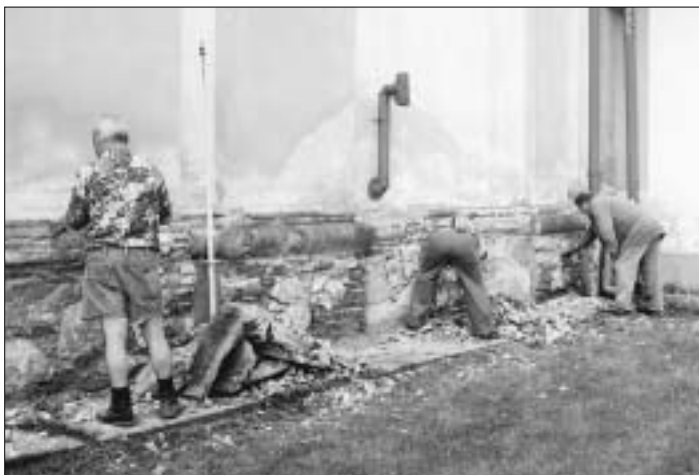
Začalo sa s opravou kostola: Otkol sa betónový sokel z vonkajšej strany. Tieto práce sa robili brigádnicky.
